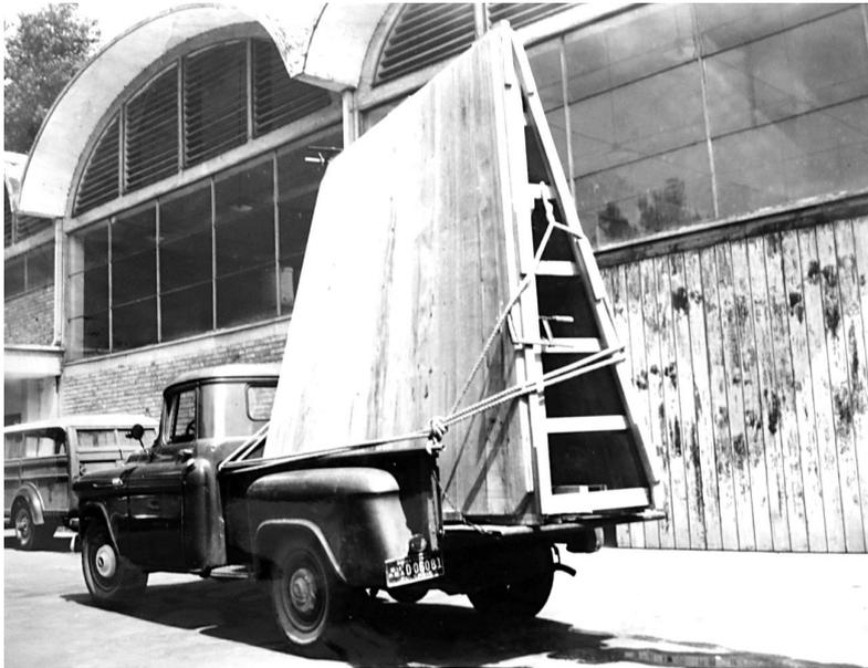
Figura 8. Encofrado de uno de los tímpanos hiperbólicos construidos en el CINVA
