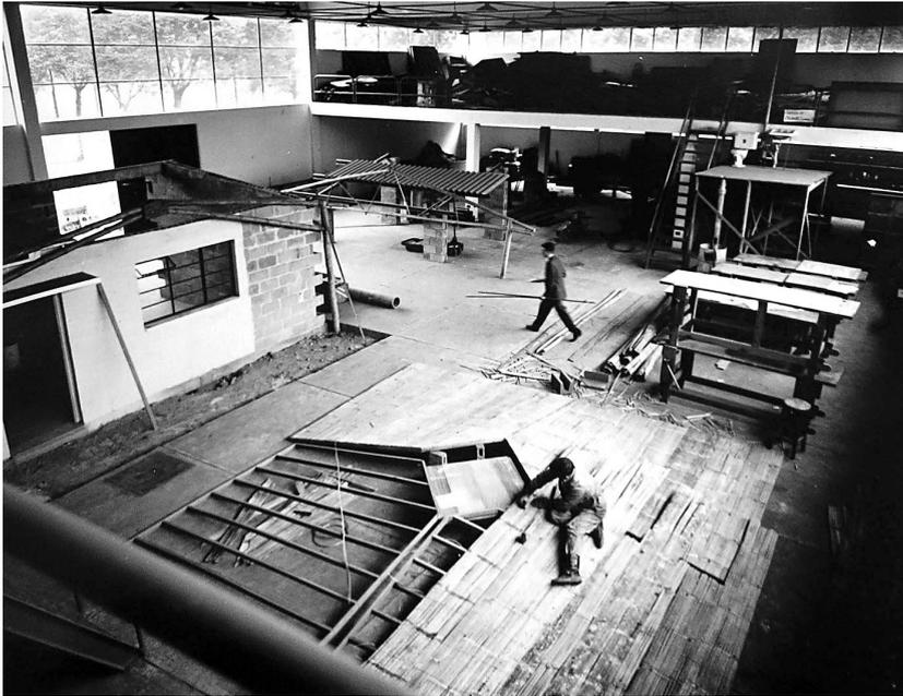
Figura 10. En primer plano, fabricación de encofrados en esterilla en los talleres del CINVA
